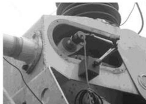
110KV SF6 开关传感器安装
