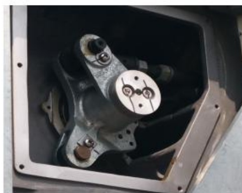
35KV SF6 开关传感器安装
