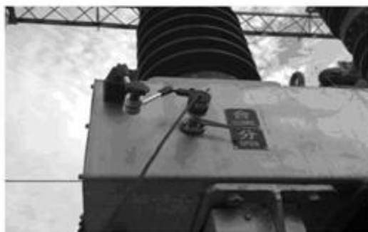
35KV SF6 开关传感器安装
