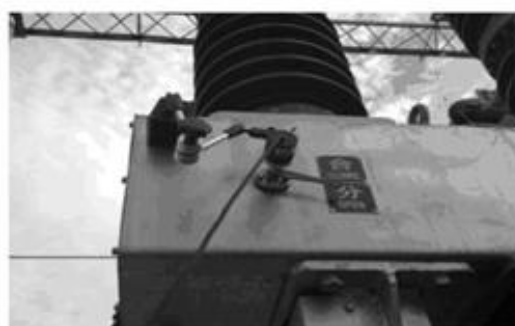
35KV SF6 开关传感器安装
