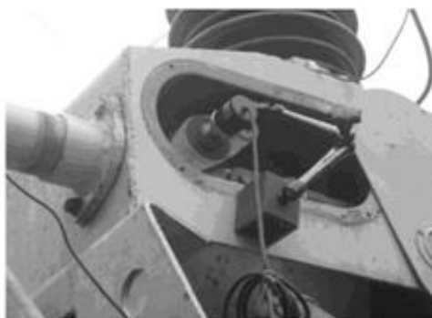
110KV SF6 开关传感器安装
