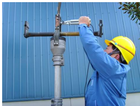
第三步 测量触指压力(已挂静触头，使测量头宽度略大于 a )
