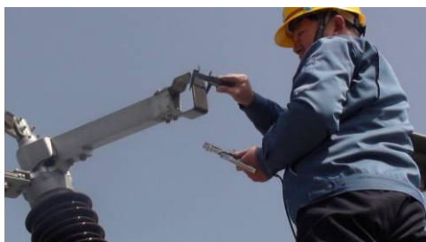
第一步 测量触头的宽度 a
