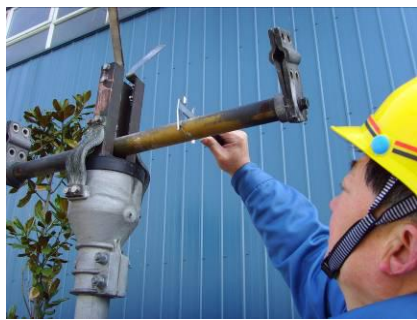
第一步 测量触头的宽度 a
