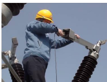
第三步 测量触指压力
