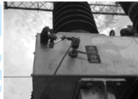
35KV SF6 开关传感器安装
