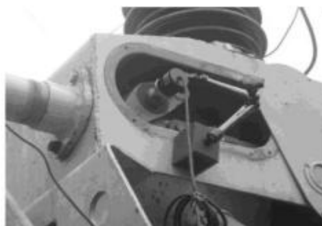
110KV SF6 开关传感器安装
