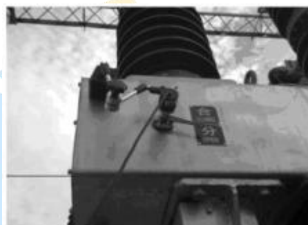
35KV SF6 开关传感器安装
